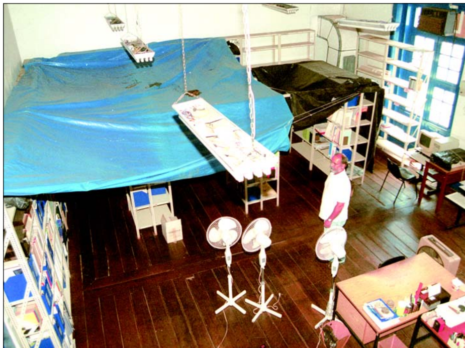
INTERDIÇÃO. Funcionários tiveram que colocar toldos para proteger os livros do acervo da biblioteca fechada pela precariedade física do prédio do IFCS
